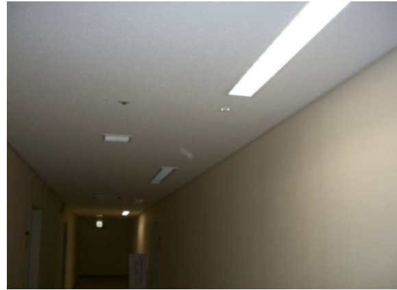
【間引き点灯の様子 病院外来棟5階】
